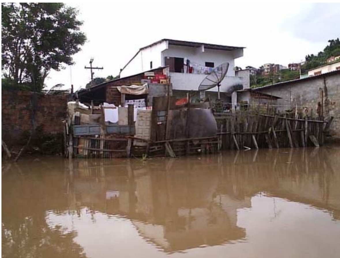
Figura 5. Impacto da urbanização descontrolada em um canal estuarino próximo ao centro da cidade de Ilhéus, Brasil. Figure 5. Uncontrolled urbanization in an estuarine channel near Ilhéus central area, Brazil.
